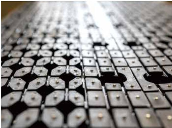
▲ゴムジョイントの表面に滑り止め用のピンを打ち込む作業。
